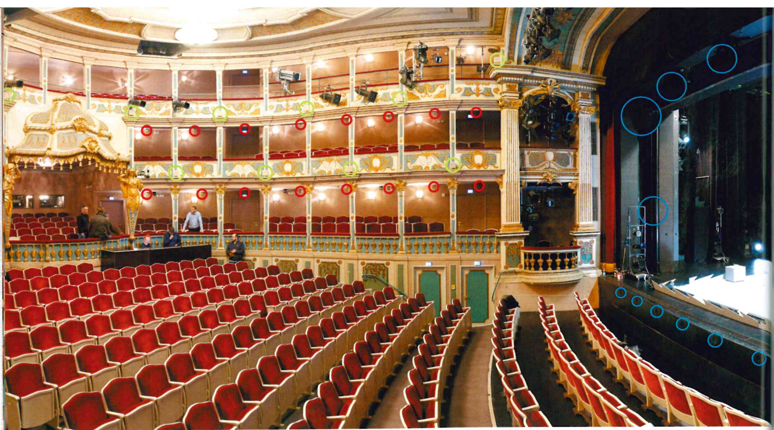
Lautsprecherplatzierung im Theatersaal: Portalbeschallung mit Frontfills (blau), L-Acoustics 5XT (grün) und X4i (rot) des Astro-Systems
