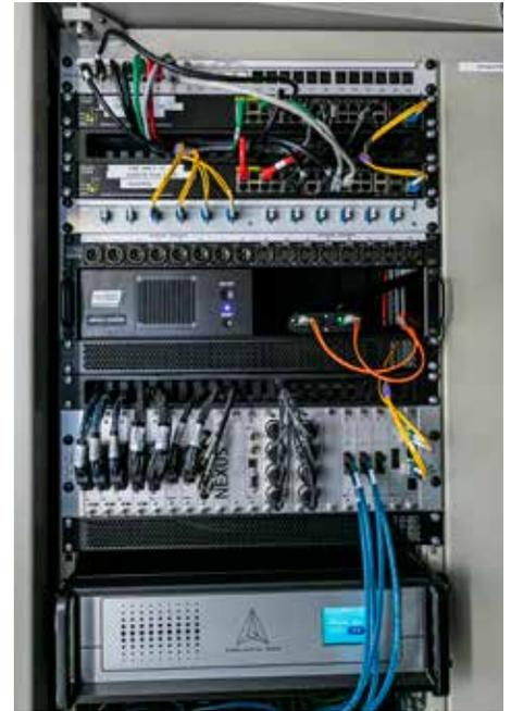
Neue Einbauten: Der Star Router von Nexus sowie ein Rack im Stellwerk mit, unter anderem, einem weiteren Nexus-Basisgerät, der Astro-Spatial-Rendering-Engine SARA II und dem Waves-SoundGrid-Server
