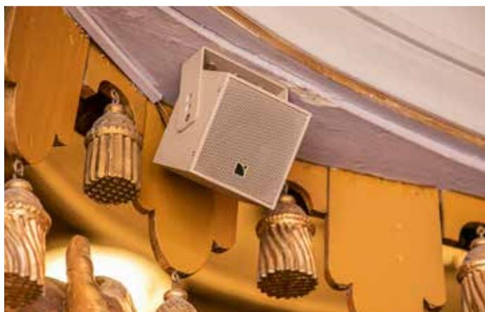
Die insgesamt 46 verbauten 4XI-L-Acoustics-Lautsprecher bilden hauptsächlich die äußeren Ringe der neuen 3D-Beschallung
